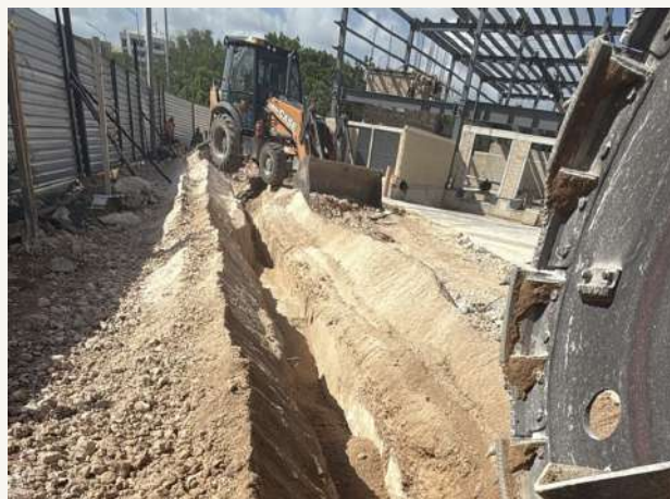
02 • Terracerías y zanjado de alta capacidad
