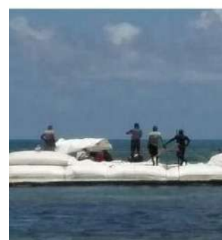
Arrecife de Concreto
